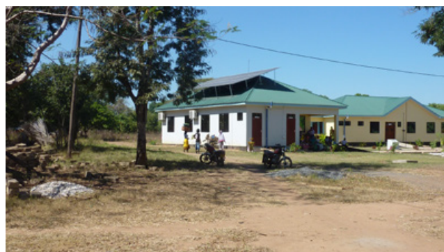
Gesundheitszentrum mit Photovoltaikanlage, Masasi Distrikt, Tansania
